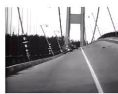
Ceci provoque dans les éléments de la structure **des efforts qui les tendent, les compriment, Les tordent, les fléchissent ou les cisailent.**
