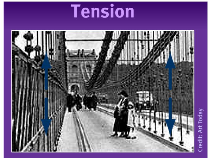
Le poids de la route et de toutes les voitures traversant tirent les câbles verticaux de ce pont suspendu. Les câbles sont étirés.
